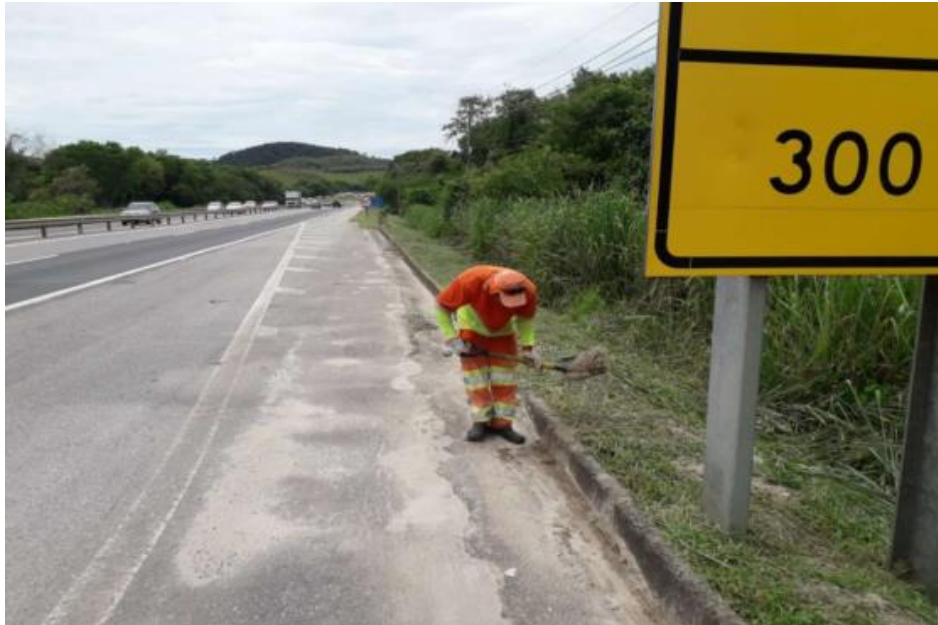
FOTO 05 - Limpeza de sarjeta – Km 03+800 Norte
