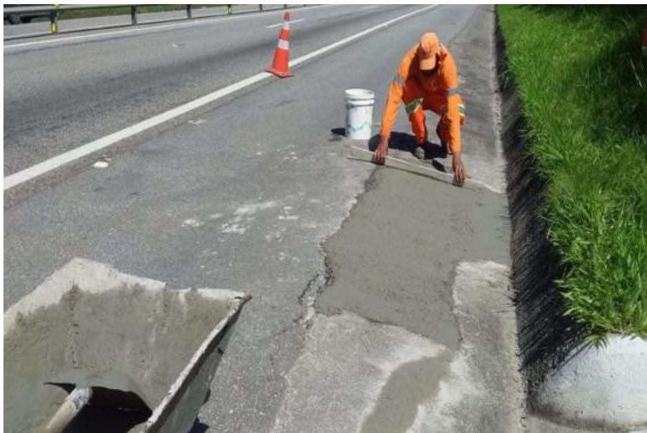
FOTO 12 - Reparo de sarjeta – Km 9+800 Norte
