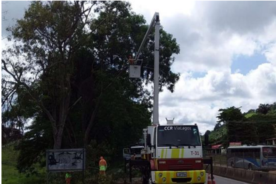
FOTO 11 - Poda de árvores – Km 13+900 Sul
