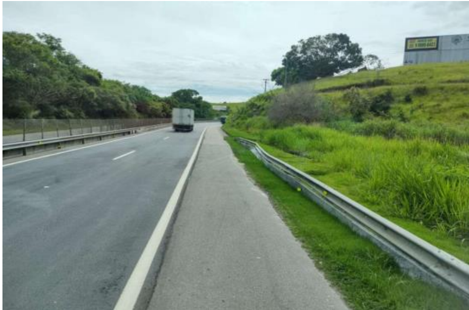
FOTO 03 - Dispositivo de segurança – Km 10+500 Norte [1]
