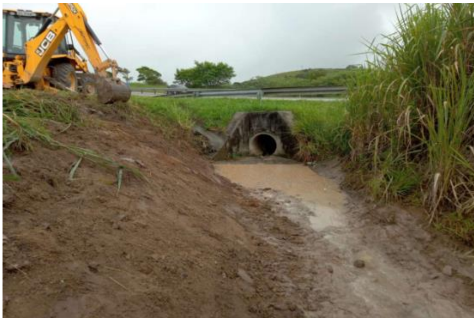
FOTO 06 - Limpeza de bueiro - Km 44+000 Norte
