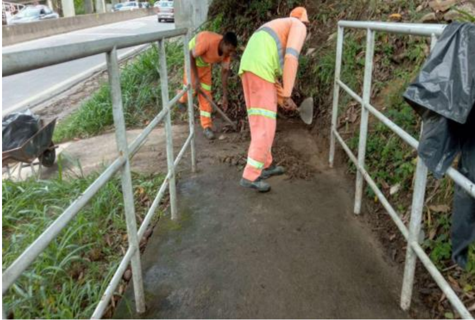
FOTO 07 - Limpeza de passarela – Km 00+400 Norte
